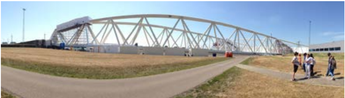
Figura N°5. Defensa de Maeslantkering, Puerto Rotterdam, en una visita en 2015. La defensa, construida en 1997, tiene dos brazos del tamaño de la Torre Eiffel y dos rótulas de 10 metros de diámetro, que son las más grandes del mundo. La compuerta se ha usado en ocasiones ante la ocurrencia de mareas meteorológicas en el Mar del Norte
