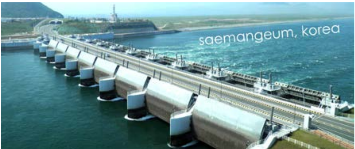
Figura N°6. Central mareomotriz en el estuario de Saemangeum, Korea, durante una visita en 2014. La planta contempla un rompeolas de 33 kilómetros –el más grande construido a la fecha- que divide el estuario del Mar Amarillo. El estuario, que eventualmente se colmatará en el futuro, de destinará a terrenos agrícolas e industriales
